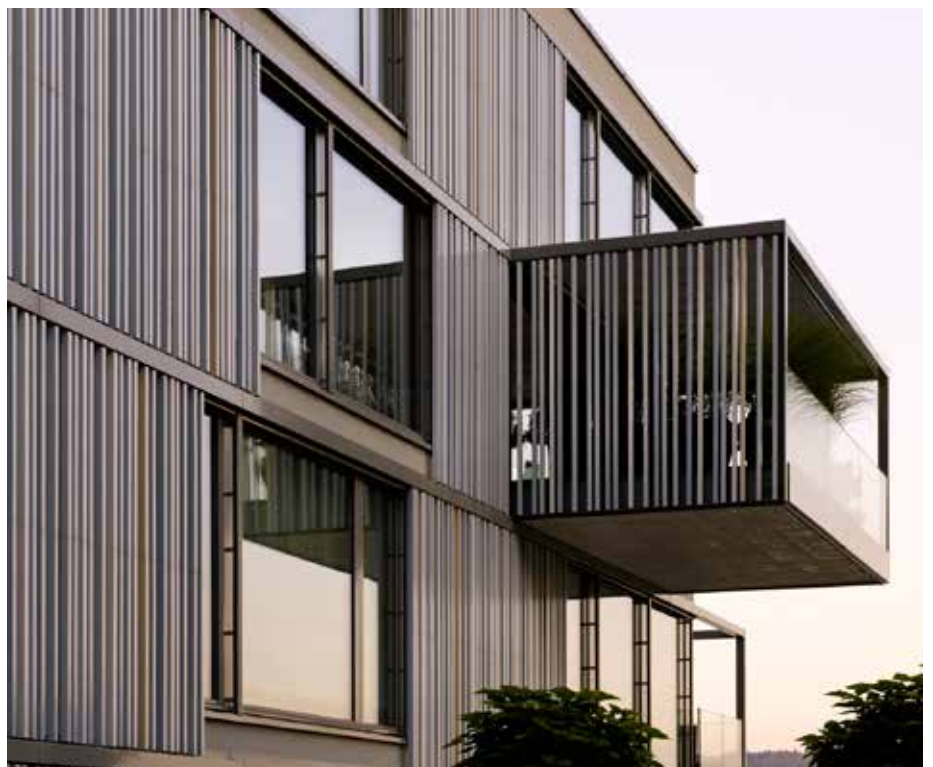
Teile der markanten Fassade und der Balkoneinfassungen wurden mit verschiedenfarbigen, geschosshohen Keramikstäben überzogen.
